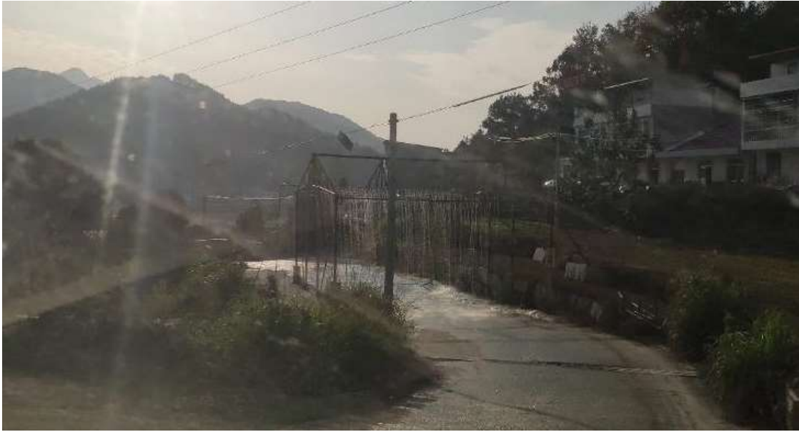
照片 2-12 南侧出场道路喷淋装置
