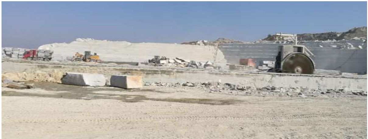
照片 2-2 采坑开采现状 2
