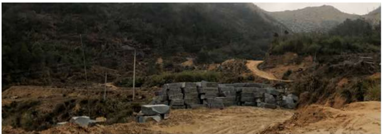
照片 2-3 荒料堆场现状
