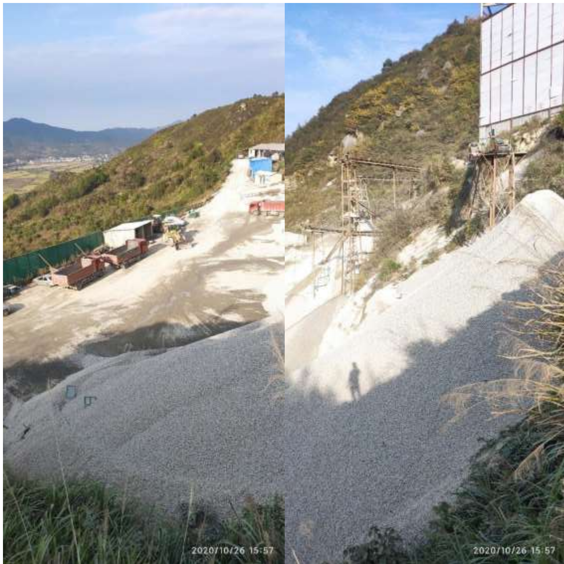
照片 2-11 矿区工厂场地北部碎石堆场
