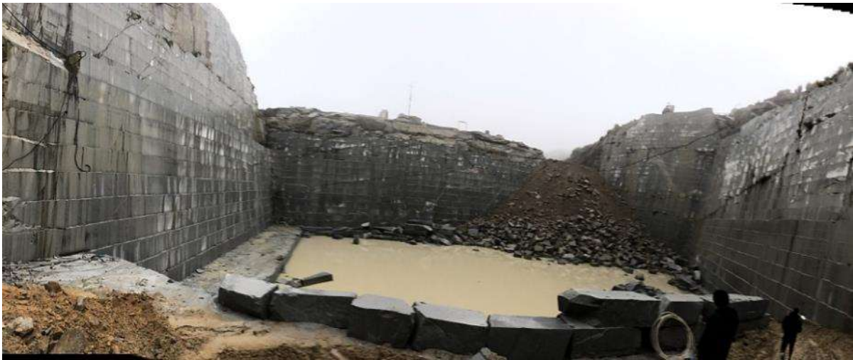
图 2.5-2 CK2 现状照片
